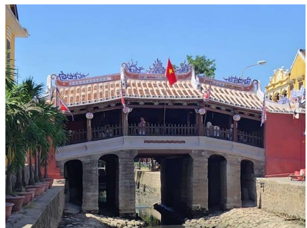
修復されたホイアン日本橋の全景
